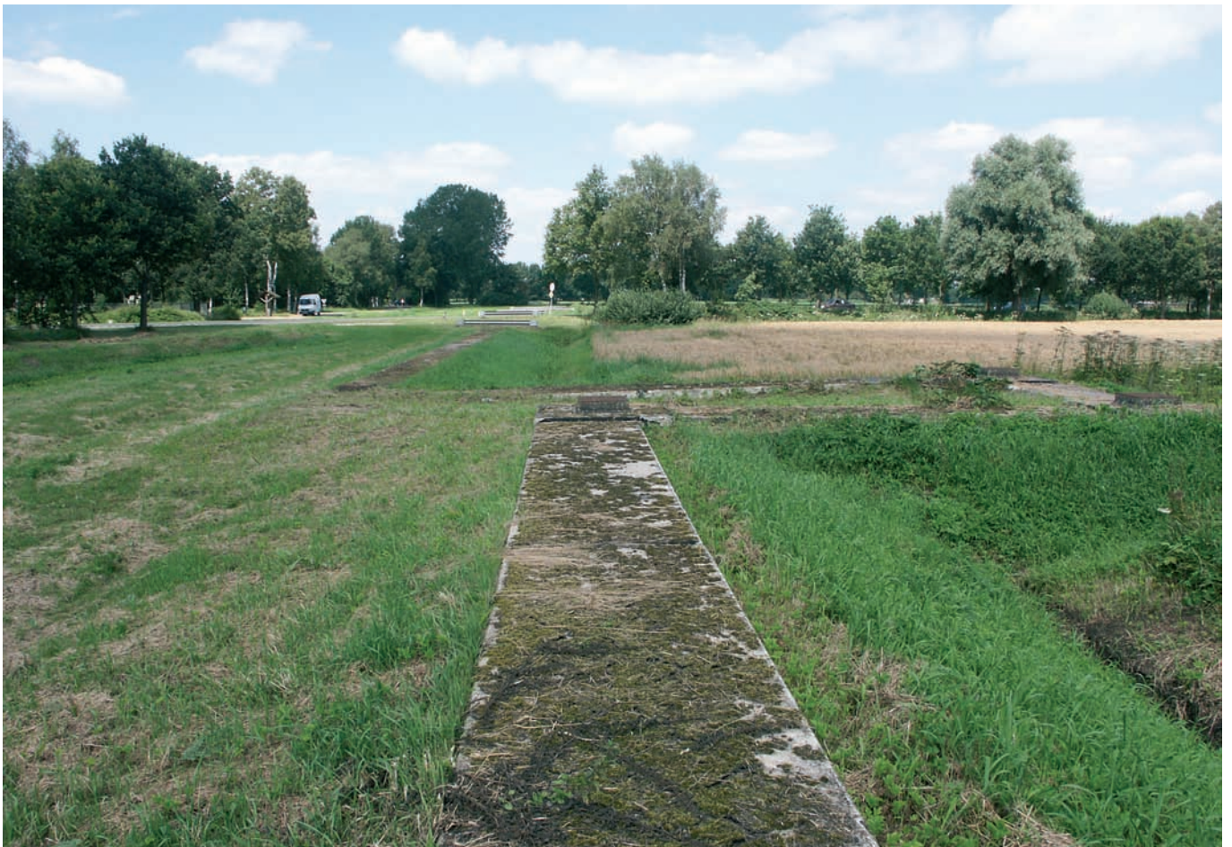
Valendisweg: goten liggen niet automatisch op maaiveldniveau en nemen veel ruimte in beslag
