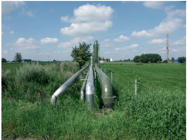
Verticale loops vormen één lijn met de leiding
