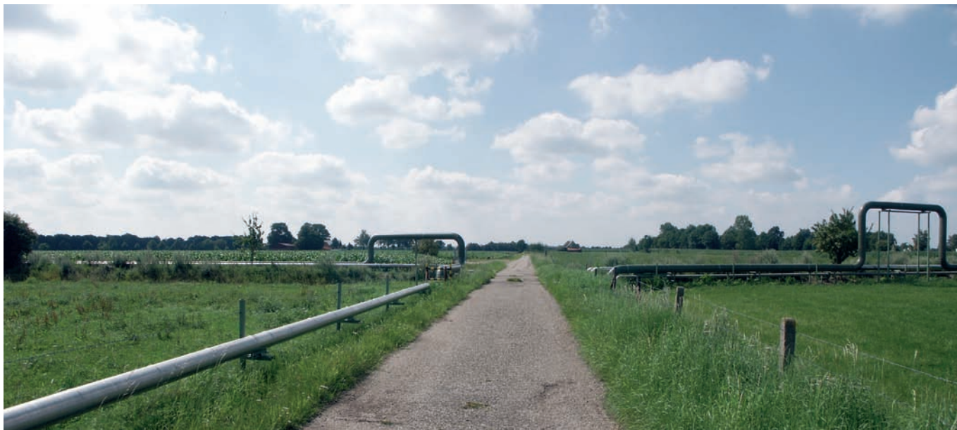
Voorbeeld uit Duitsland: de leiding duikt onder de weg door
