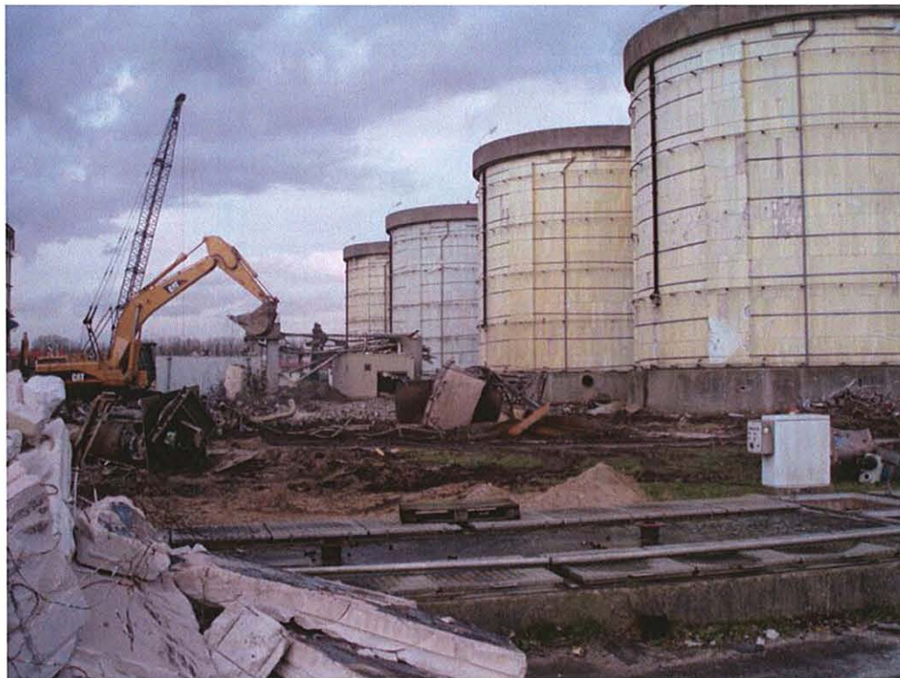
Foto2 Sloopwerkzaamheden eind 2006 in RI Oost
