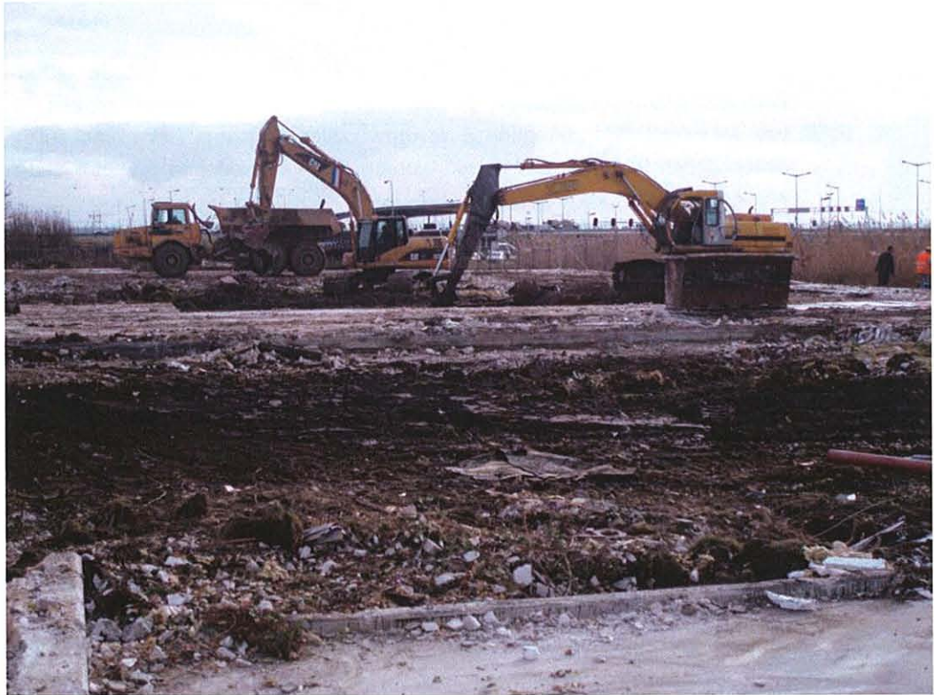
Foto 1 Sloopwerkzaamheden in deelgebied RI Oost.
