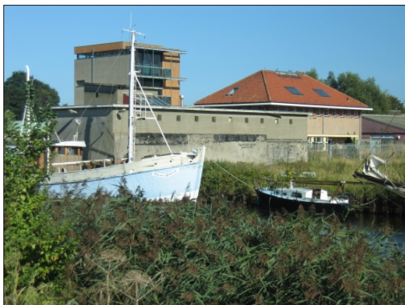
Voormalig zoutsilo en dienstgebouw, Papaverhoek
