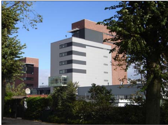
Bedrijfsverzamelgebouw Kaap Noord, Asterweg
