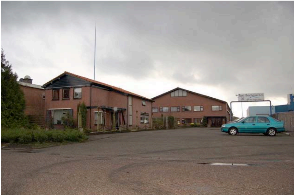
Foto Voorbeeld van hoge bebouwings- en verhardingsdichtheid op Industrieterrein Haven; woning, bedrijfspand en grote oppervlakte bestrating.
