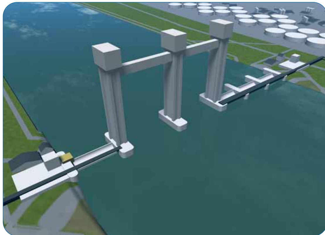
> Figuur 6: Basisontwerp van de geplande stormvloedkering te Oosterweel
