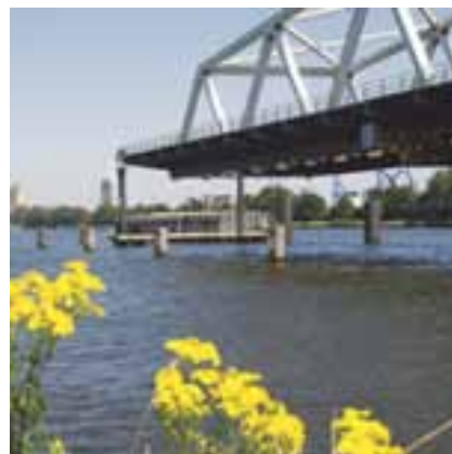
N62; brug Sluiskil
