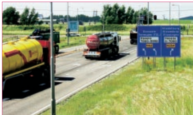
De kruising van de Sloeweg met de Bernhardweg en de Tunnelweg wordt momenteel geregeld door verkeerslichten.
