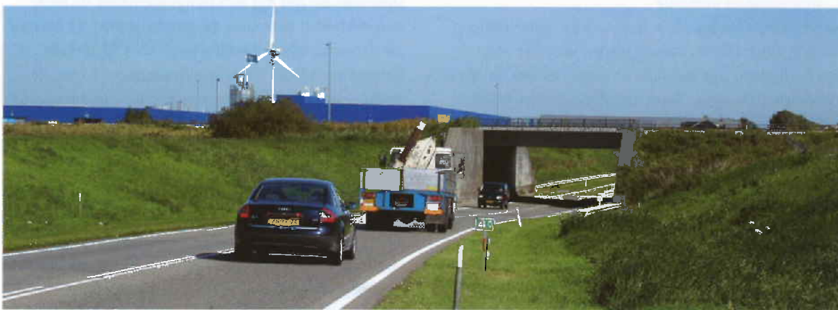
Tunnel in Rijksweg 31 onder het spoor naar Sneek
