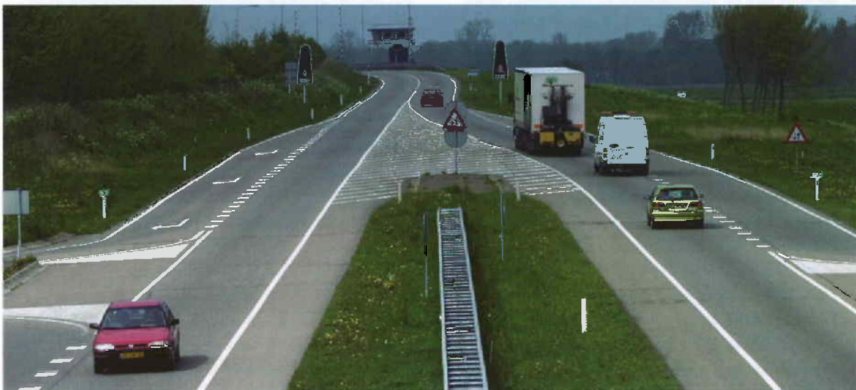
Ongelijkvloerse aansluiting op de rijksweg 31 bij Deinum
