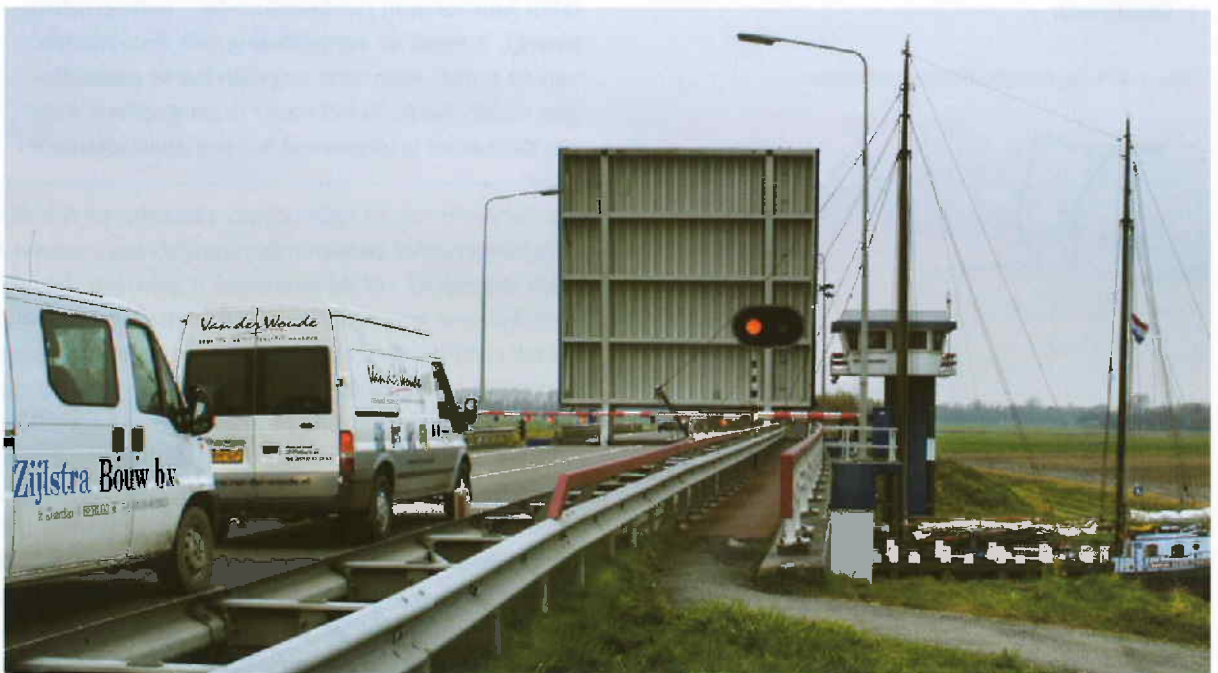
Brug bij Deinum over het van Harinxmakanaal leidt tot oponthoud voor verkeer op de Rijksweg 31
