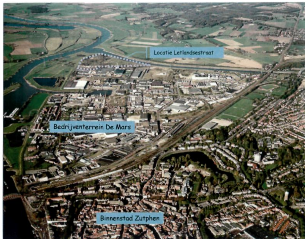
Foto 1.1: luchtfoto van bedrijventerrein De Mars
