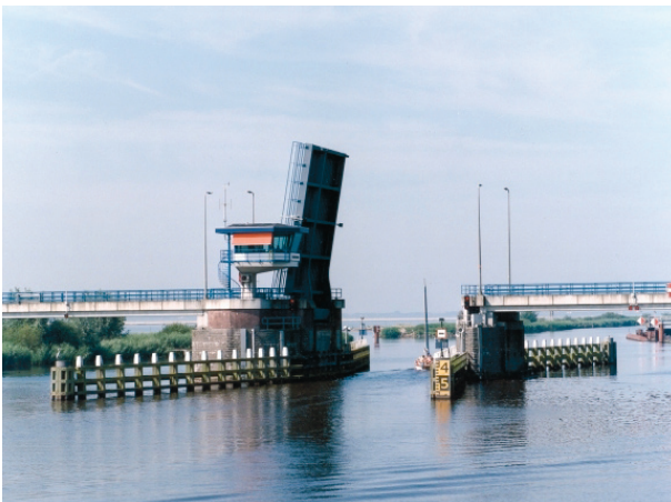
Figuur 4.8 Brugopening vanaf water
