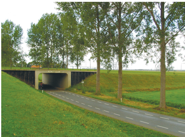
Figuur 4.6 Viaduct in de Ramsweg
