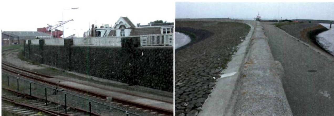
Figuur 2. Links: kademuur langs het spoor bij station Harlingen-Haven. Rechts: Zuidelijke havendam met zicht op de havenmond
