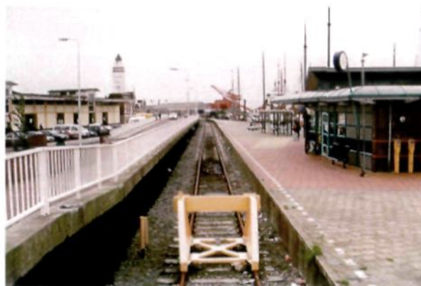
Foto 2-2 Het bestaande spoorwegperron
