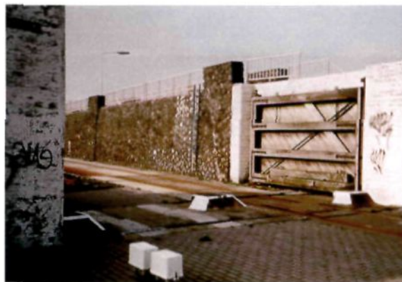
Foto 2-1 De bestaande spoorwegcoupure
