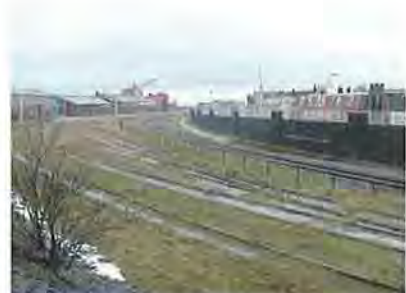
Huidige situatie rangeerterrein
