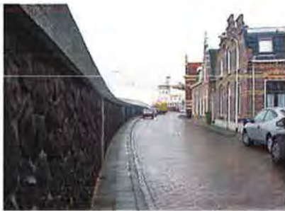
Huidige situatie bij bestaande bebouwing.
