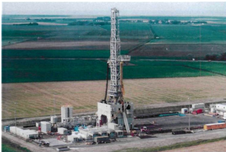
Figuur S1: Voorbeeld boortoren met bijbehorende installaties
