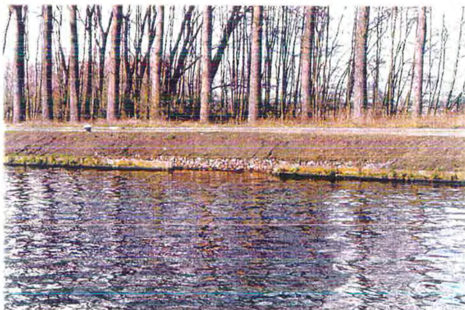
Fauna-uitstapplaats in Wilhelminakanaal ter hoogte van Goorloop (knelpuntnr. 152 en 33)
