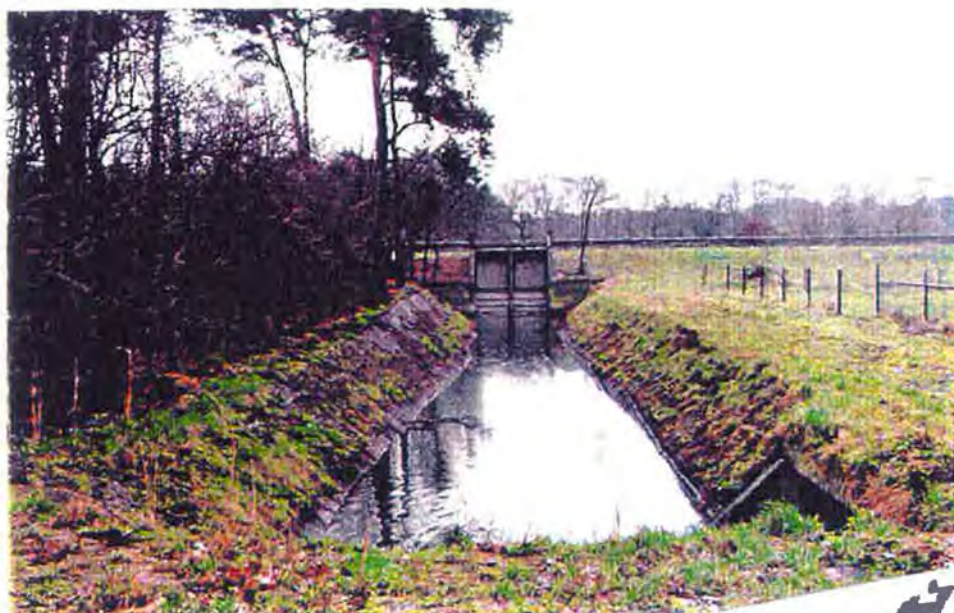
Knelpuntnr. 9: De Zandlei Oplossing: aanpassen duiker of (i.v.m. waterkerende functie dijk) zoeken naar mogelijkheid voor andere passagemogelijkheid.
