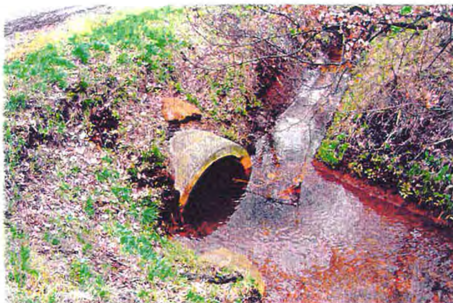
Knelpuntnr. 124: De snelle loop Oplossingsrichting: aanleg ecoduiker.
