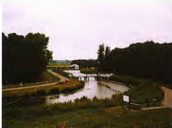
Brug over de Ringvaart
