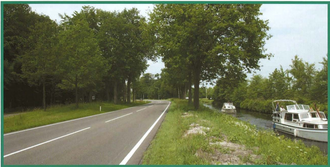
Duikerconstructie Compagnonsvaart bij Ontwijk, duikerconstructie, tracé vaart westzijde.
