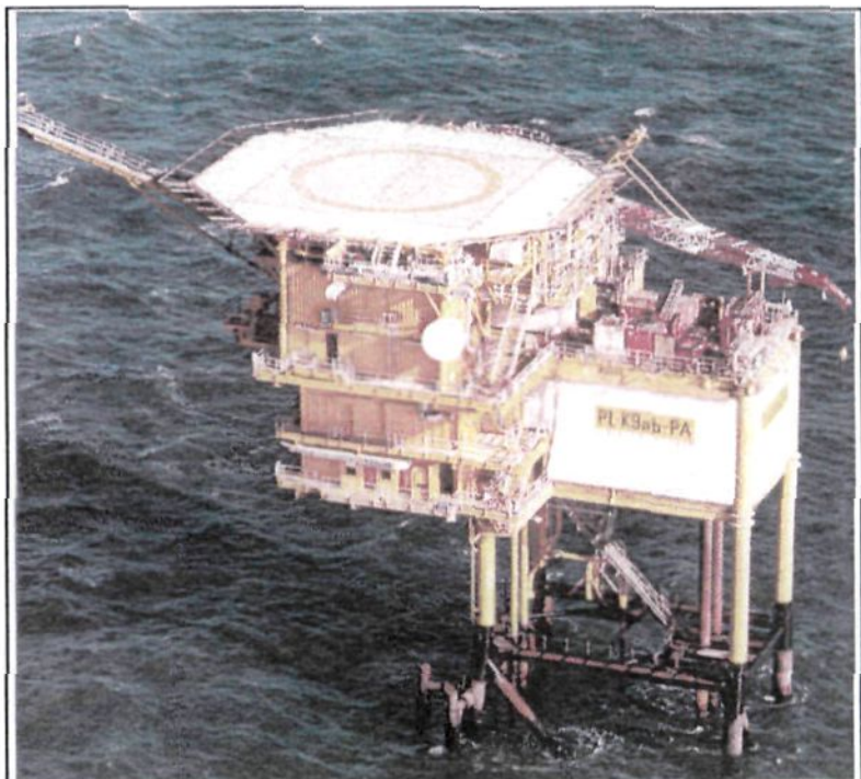
Figuur 1.4-1: Foto van een bestaand platform vergelijkbaar met G17d-A
