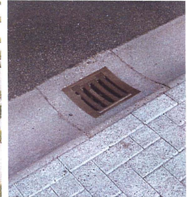
Afwatering Betonnen molgoot
