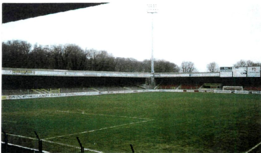
Foto 1 Het huidige stadion
