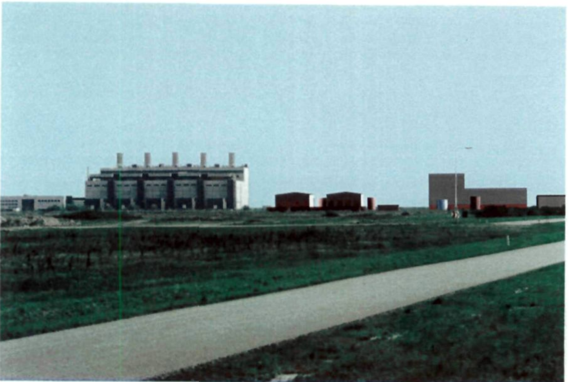
Foto F1 Visuele impressie van de vergassingsinstallatie (rechts) naast de bestaande Eems-centrale vanuit het zuidwesten gezien
