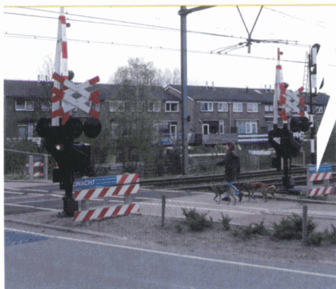
Spoorwegovergang ten zuiden van Bergen op Zoom
