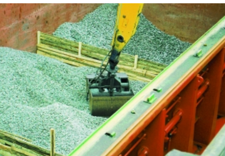
Door nieuwe havenfaciliteiten neemt het spoorverkeer toe
