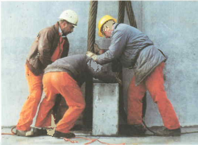
Hijstropen worden vastgemaakt aan een betonnen fundatie voor een windturbine van het Deense offshore windpark Tunø Knob.
