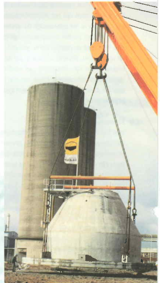
De fundatie wordt gehesen door een drijvende bok. (Foto's: John Petersen/ Smit Internationale)
