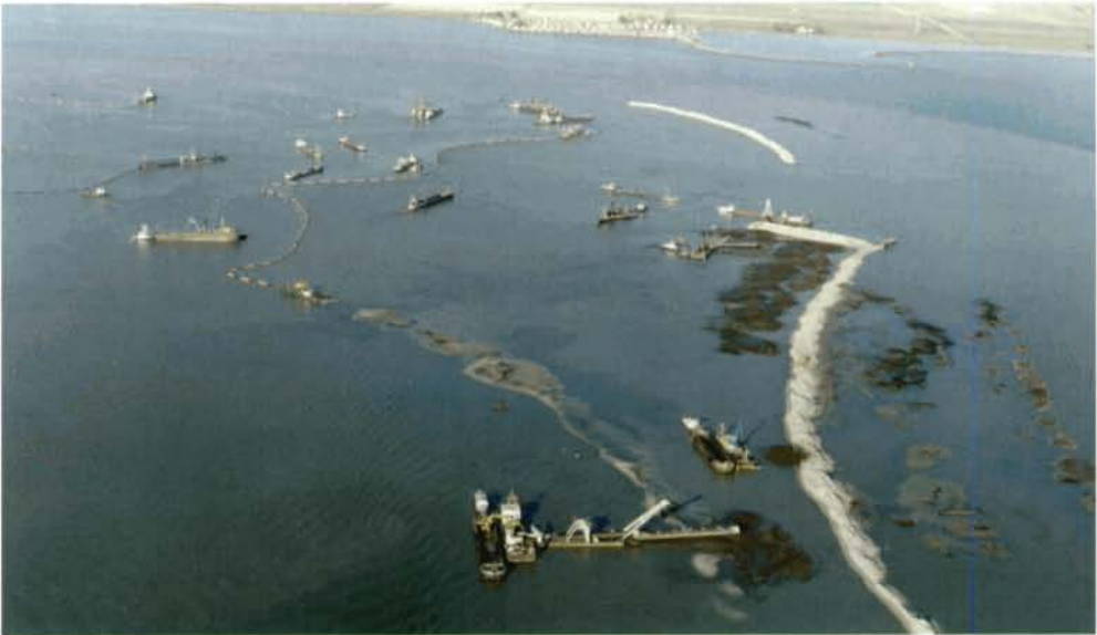
Voorbeeld benodigd materieel aanleg omdijkt depot. (IJsseloog, 1998)
