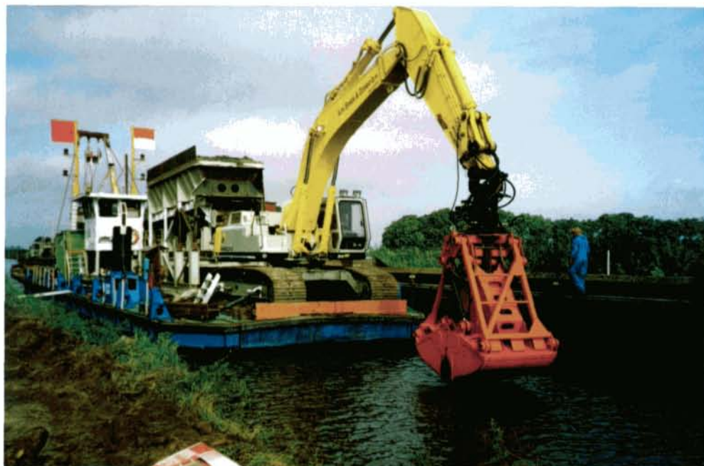
Saneringsbaggerwerk met een milieuknijper
