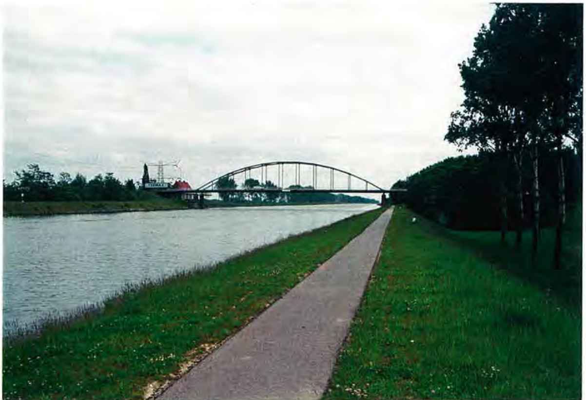
De brug over het Julianakanaal bij Roosteren
