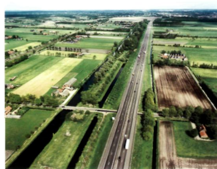
Fig. 4.7 Aerial opname van de 2 x 2 viaducten ten noord van Heuvelse steeg. Boven is het noordelijke aanvalspad naar de tolkruising
