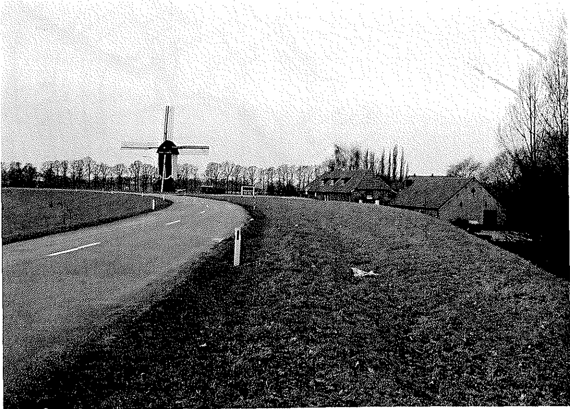
foto 4 dijk met brede kruin, flauwe taluds, verbreed grondlichamen en brede weg
