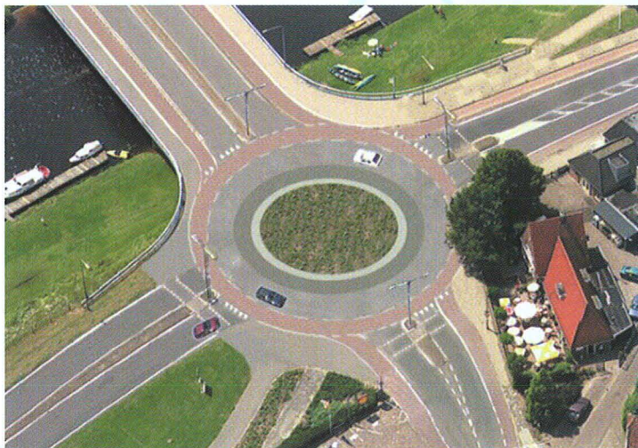
Na aanleg van de tunnel wordt het kruispunt bij de Hessel Mulertbrug een stuk rustiger. In dat geval kan daar eventueel een rotonde worden aangelegd.
