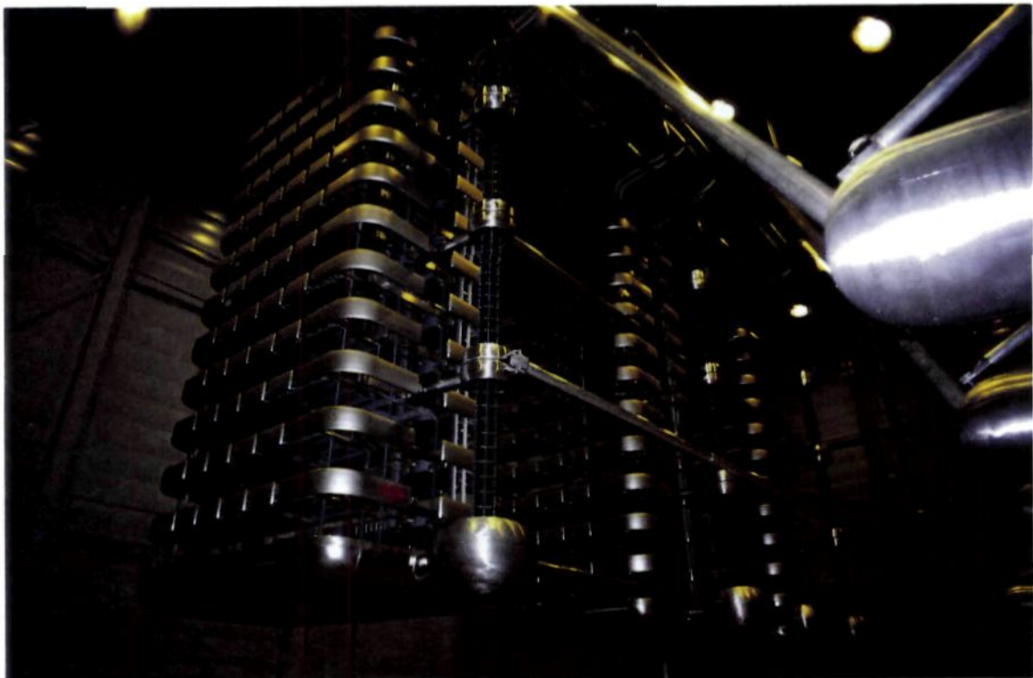
Figuur 4.4.1.a Binnenaanzicht converterstation
