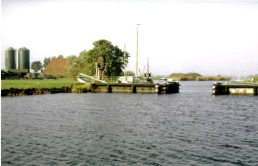
De keersluizen worden gereconstrueerd
