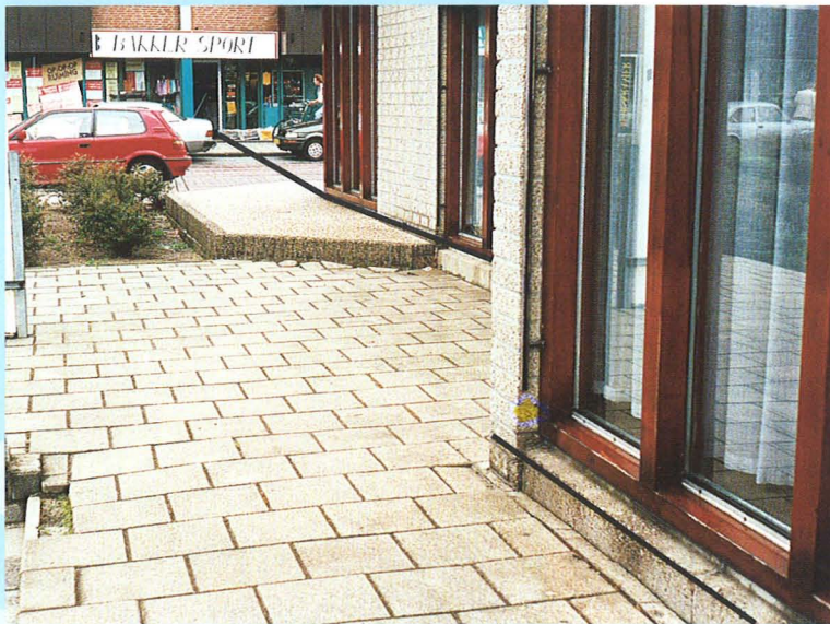
De lijn geeft het laagste stuk van de waterkering in het zuidoosten van Urk aan.
