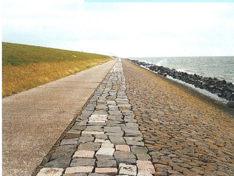
Buitenbeloop van de Westermeerdijk
