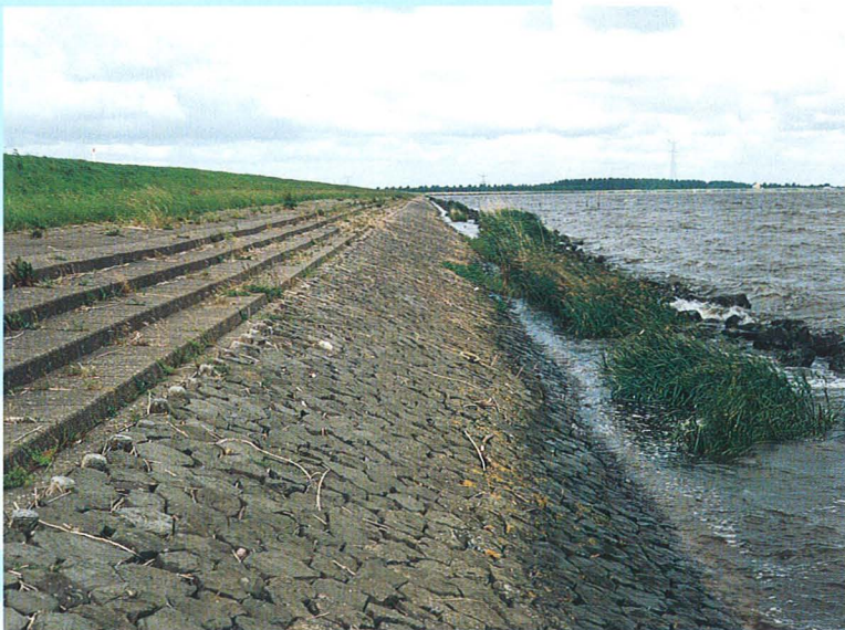
Bekleding van de Ketelmeerdijk
