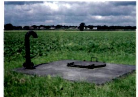
Rond pompstation Borgharen is een kleischerm gepland
