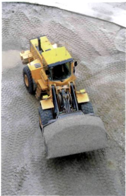
Bulldozers verdichten de gestorte klei
