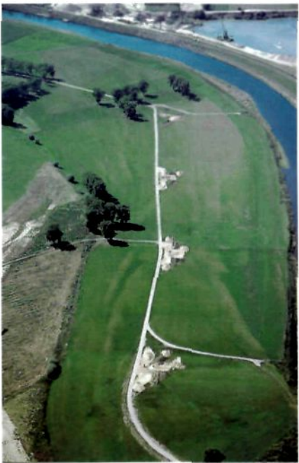
Oeverfiltratie te Roosteren
