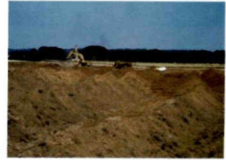
Aanleg van kades
