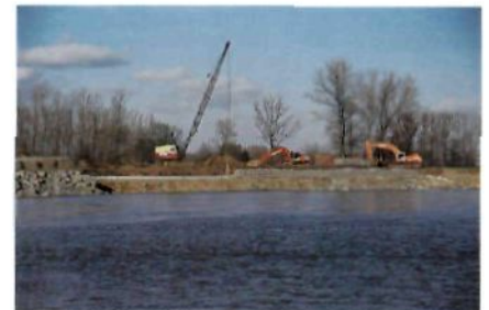
In de Voorkeursaanpak worden vier grensoverschrijdende leidingen verlegd
