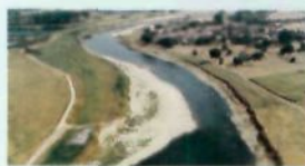
Vorming van nieuwe aardkundige waarden wordt groter door uitvoering van het Grensmaasproject.
