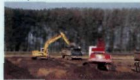
Graafwerkzaamheden tasten de kwaliteit van aardkundige waarden aan.
