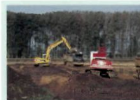
Graafwerkzaamheden veroorzaken op sommige locaties geluidhinder.
