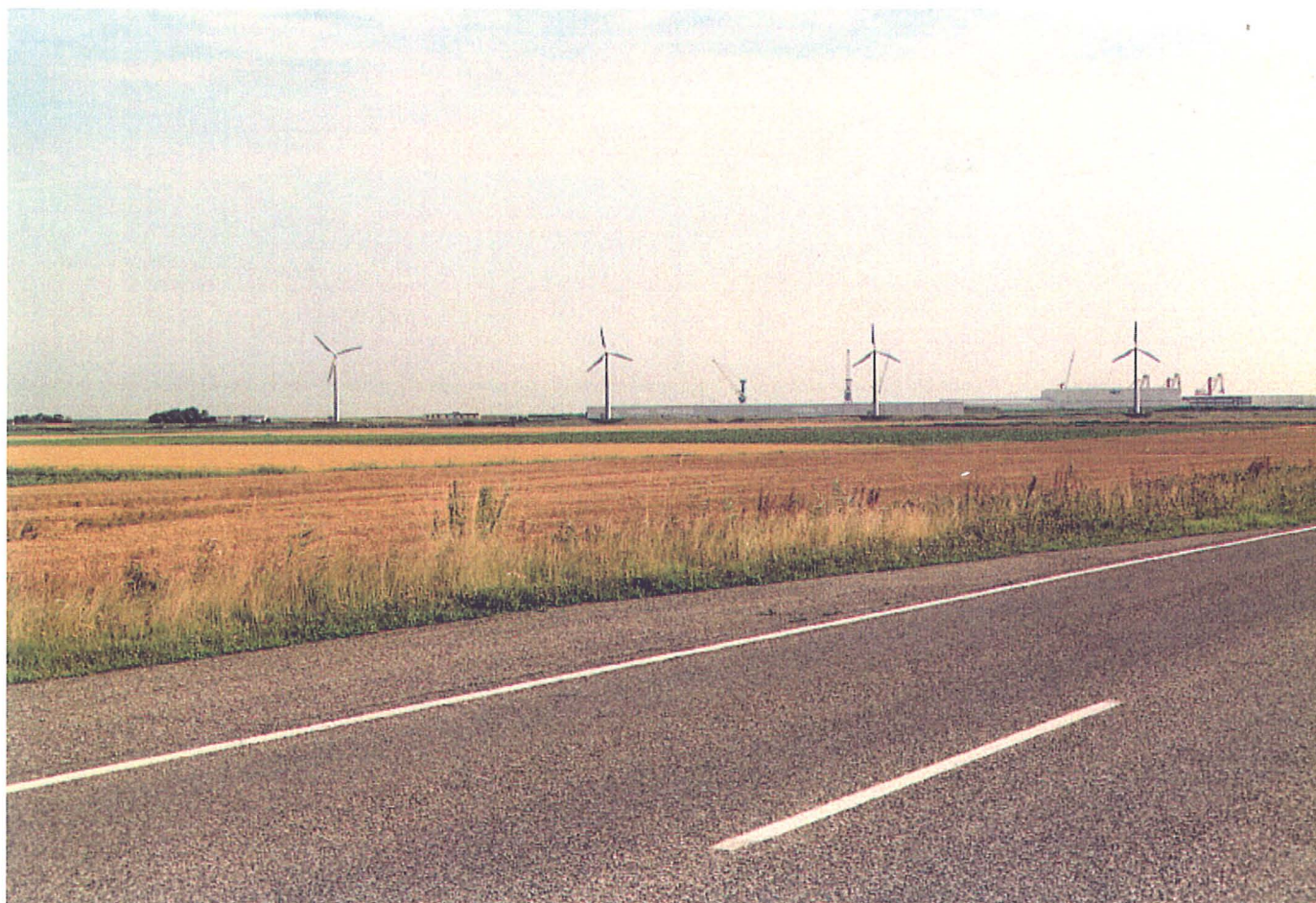
Figuur 6.10.a Fotopunt 3: Huidige situatie locatie Eemshavendijken
