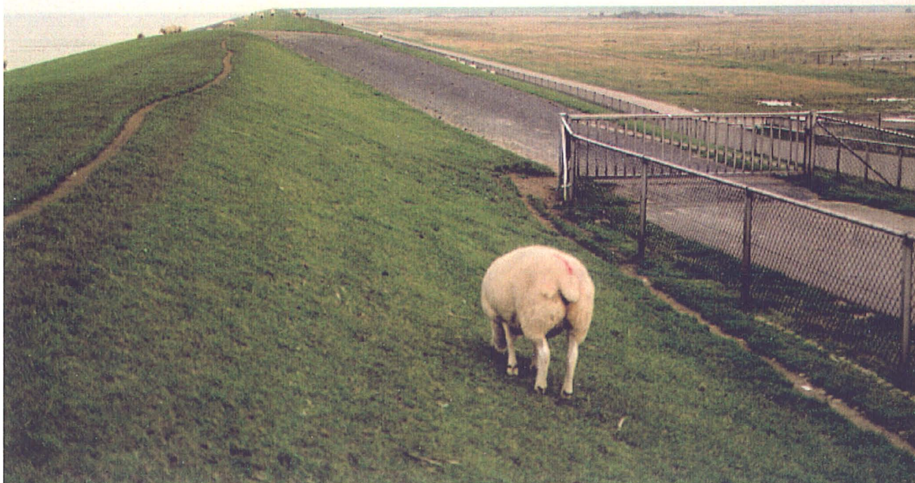
Figuur 6.11.a Fotopunt 4: Huidige situatie locatie Eemshavendijken
