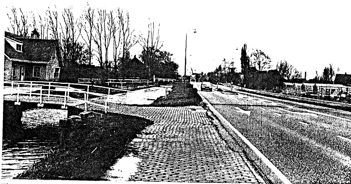
Figuur 6.2/1 a) Heulweg, bestaande situatie
