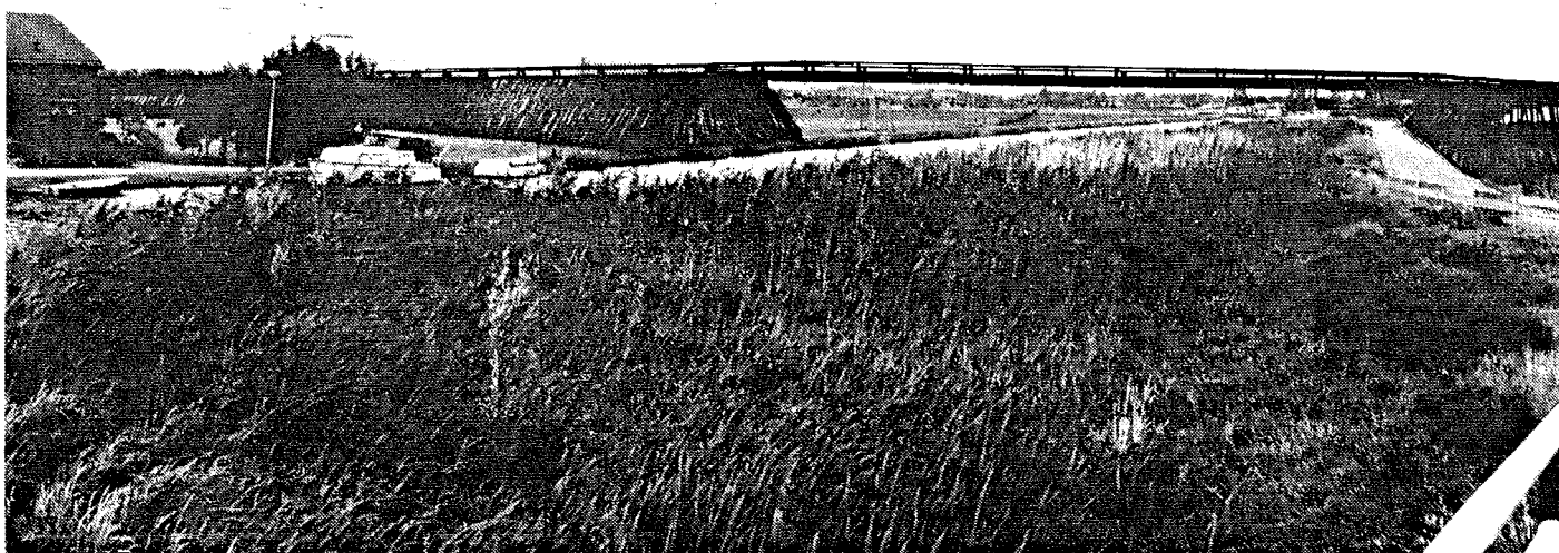
Figuur 6.2/4 b) Zweth met viaduct N54
