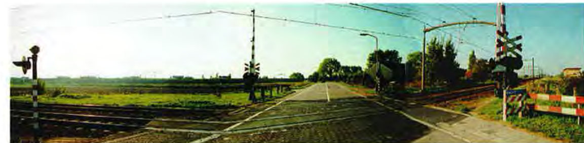
Bestaande situatie overweg Hoofdstraat
