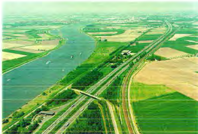
Luchtfoto Dordtsche Kil gezien in noordelijke richting
