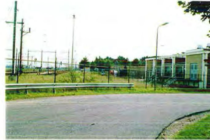
Huidig onderstation bij Kijkhoek
