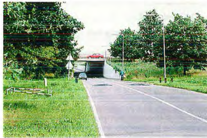
Huidige onderdoorgang Molenweg
