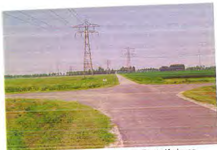
Huidige situatie kruising Lange Dam en Eerste Kruisweg
