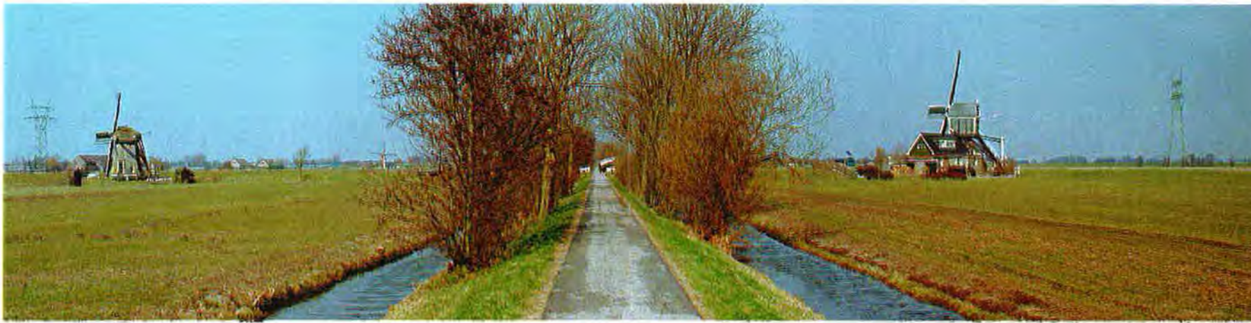
bestaande situatie fietspad Ruige Kade
