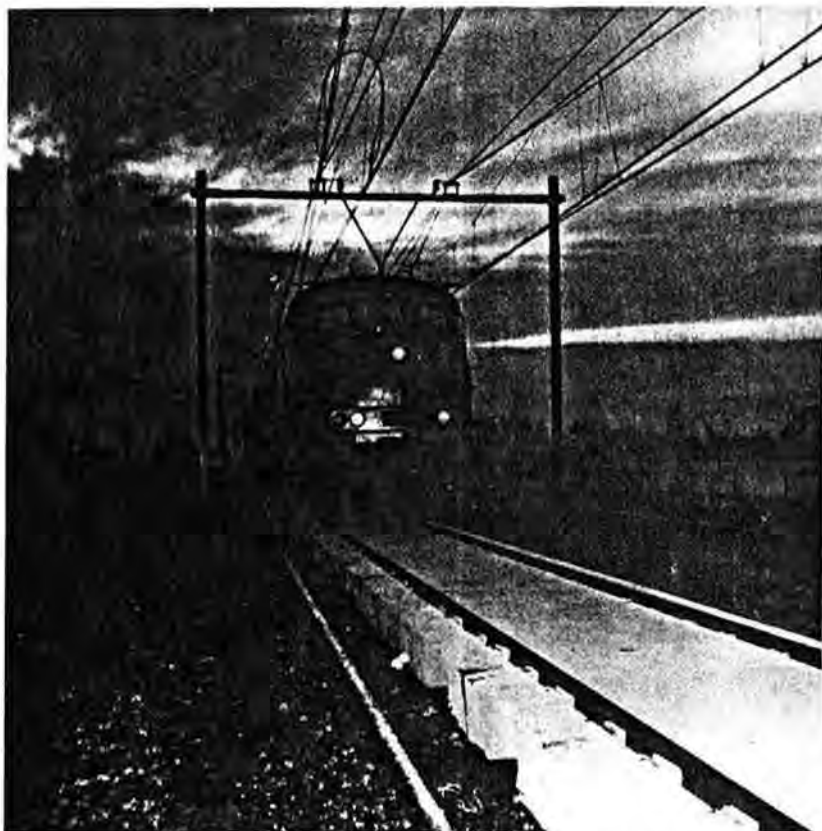
Foto 6: UIC 54 op betonplaten, lang 6 m, nog niet aangevuld met ballast.
