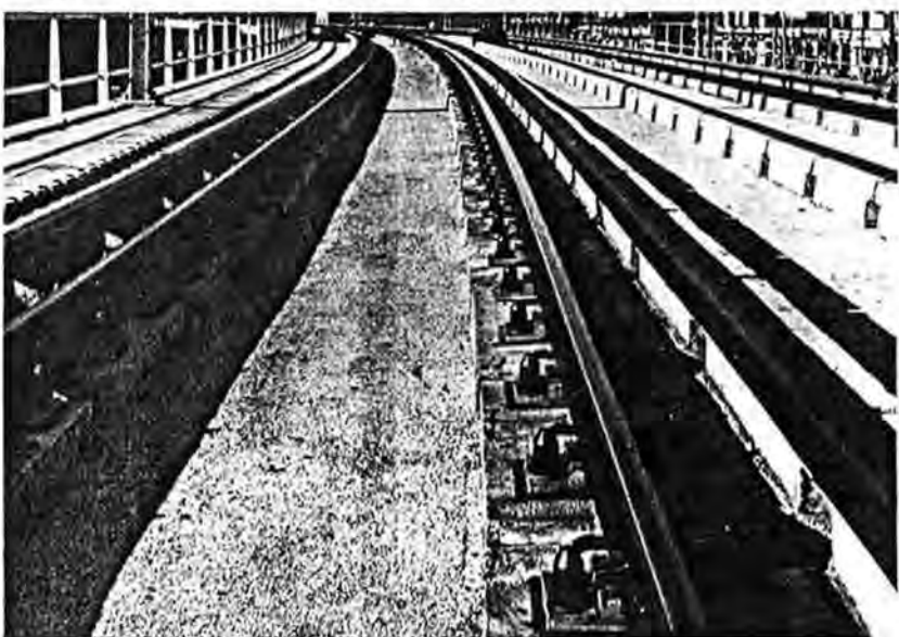
Foto 2: Spoorconstructie op brede rughellingplaten, die rechtstreeks met behulp van ingebetonde ankers op het betondek bevestigd worden.
