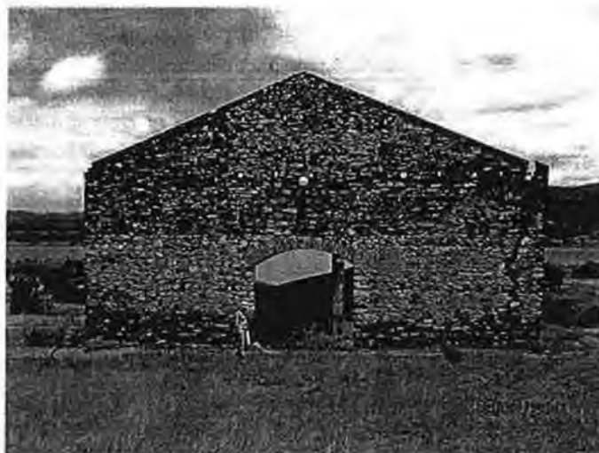
Ruína da Administração Colonial portuguesa na localidade de Benga, próximo à Cidade de Tete, do lado oposto do Rio Zambeze ao fundo.
