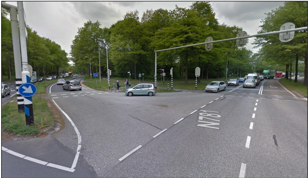
Figuur 30. De huidige situatie kruising Nijenoord Allee-Mansholtlaan te Wageningen, met enkele aanwezige spanningsvoerende elementen (stoplichten). Kijkrichting NNW. Bron: Google Earth.
