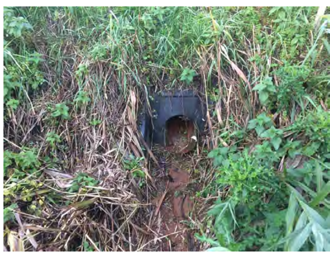
Foto 23 lozingspunt westelijk gelegen oever.
