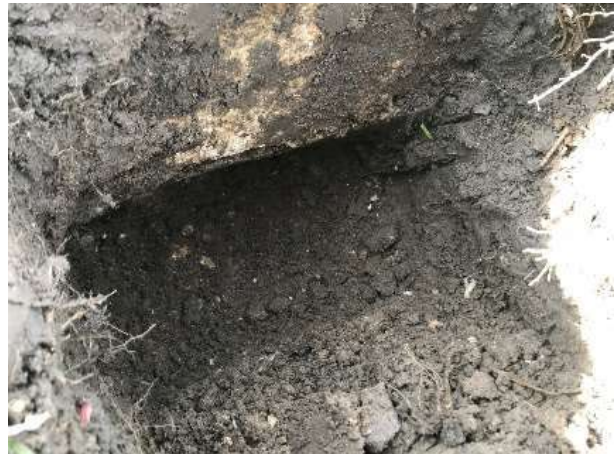
Figuur 8 fundering onder betonpad, 18 maart 2020
