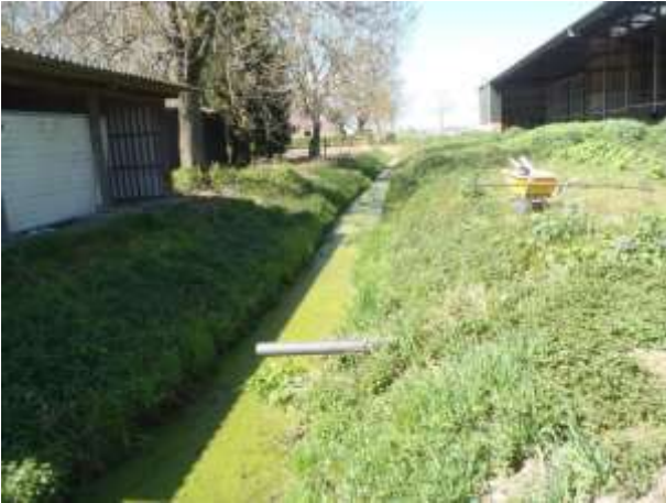
Figuur 10 Oeverbescherming en lozingspunt SL63, SL64 En SL65
