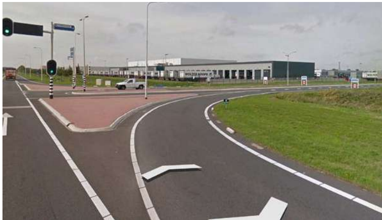
Bestaande entree Trekkersveld III
