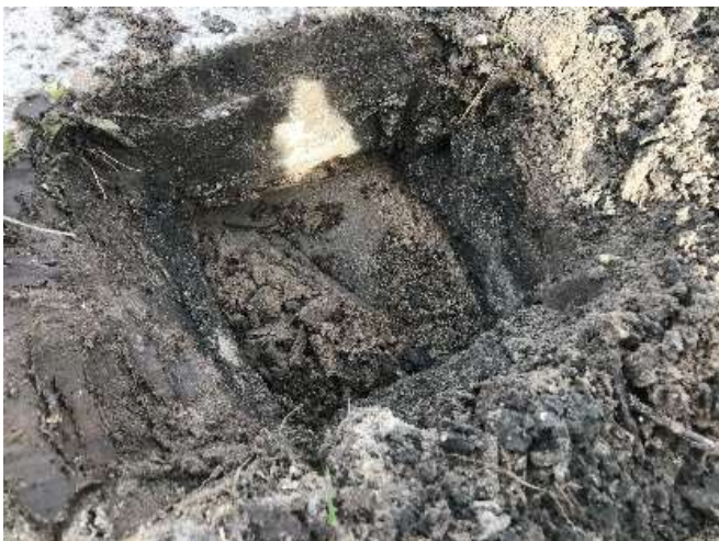
Figuur 9 fundering onder betonpad, 18 maart 2020
