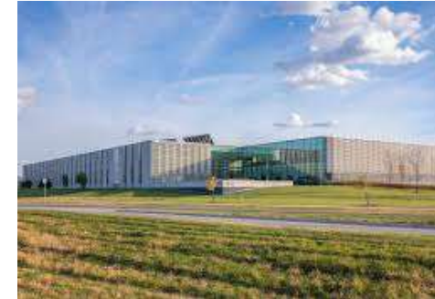
Deels open gevel en grijze gevelplaten
