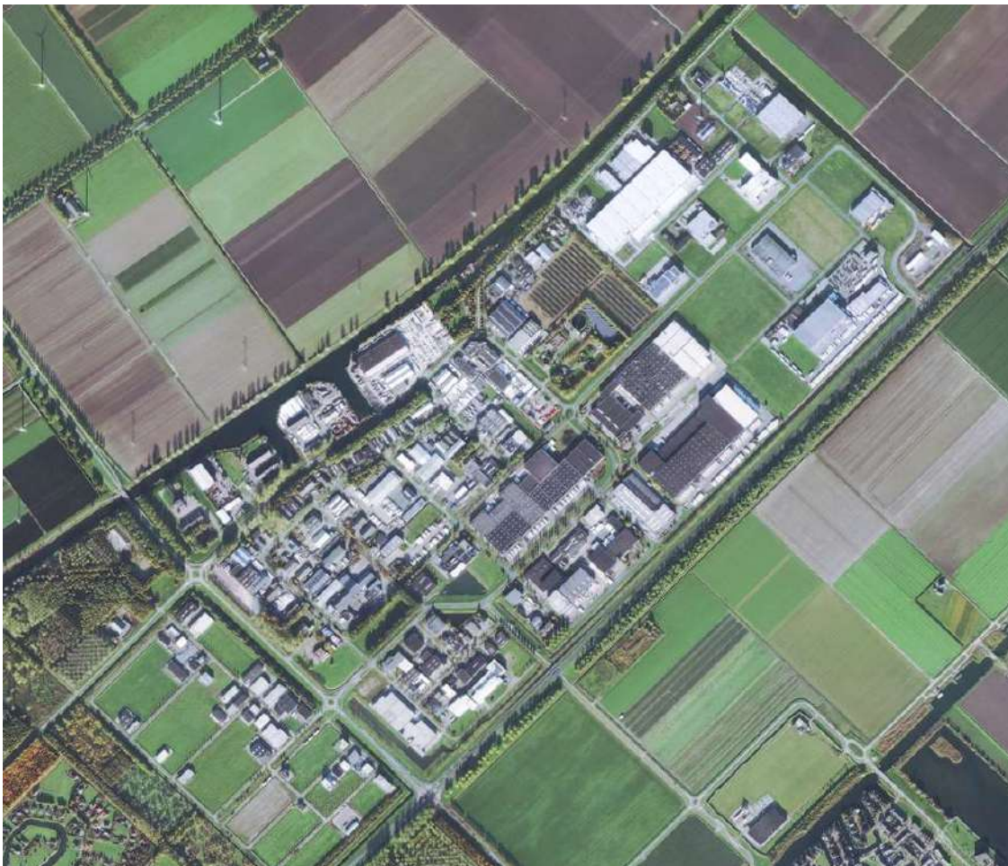
Figuur 3-1 Luchtfoto van de bedrijventerreinen Horsterparc en Trekkersveld (bron: Satellietdataportaal.nl)
