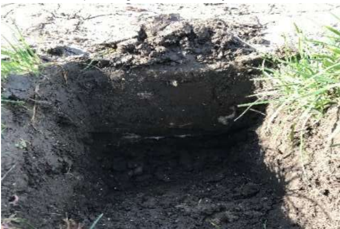
Figuur 7 fundering onder betonpad, 18 maart 2020
