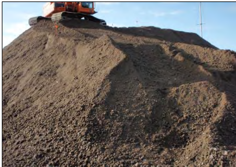
P2016-0548, Partijkeuring menggranulaat Zeewolde, foto 2
