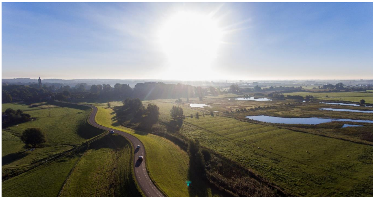
Figuur 4.4 Luchtfoto dijkvakken 1, 2 en 3.
