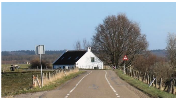
Figuur 4.9 Maatwerklocatie 3B. Dijkvak 3, ter hoogte van dijkpaal 28/29.
