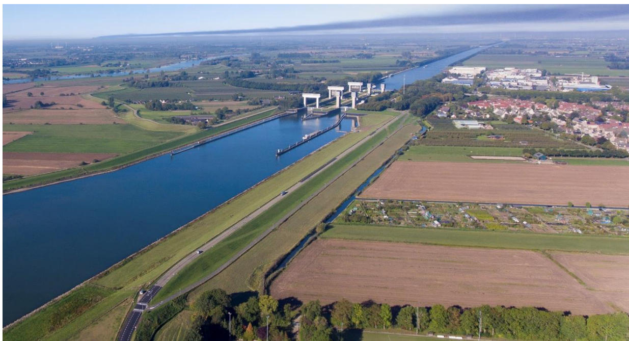
Figuur 4.22 Luchtfoto dijkvak 16.
