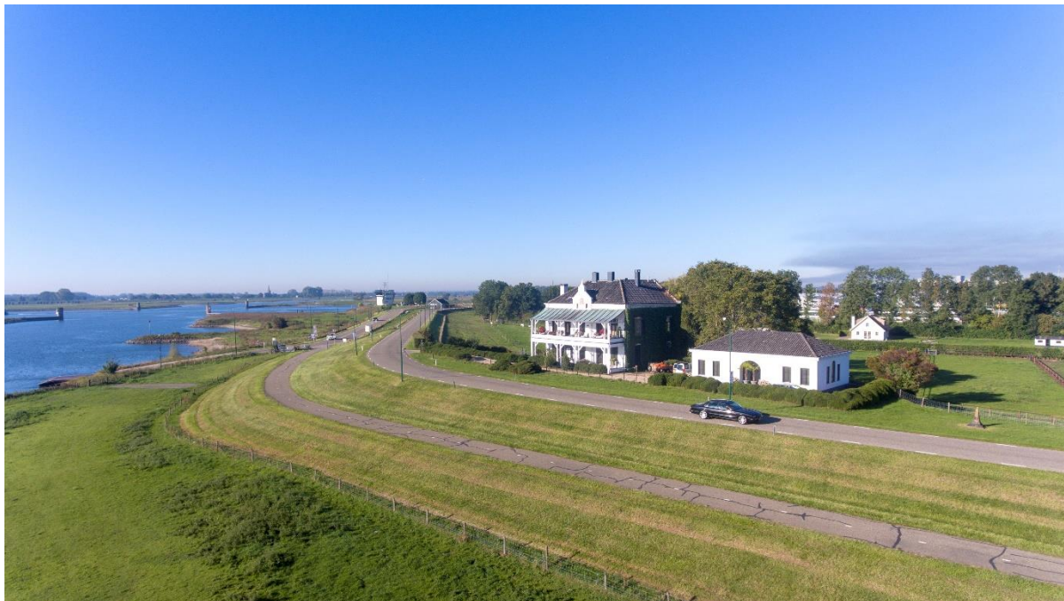
Figuur 4.20 Luchtfoto dijkvakken 13 en 14.
