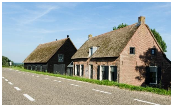
Figuur 4.8 Maatwerklocatie 3A. Dijkvak 3, ter hoogte van dijkpaal 20.
