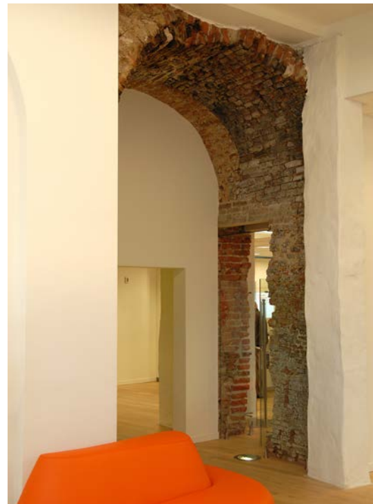
Restanten van de vestingwerken zijn zichtbaar gemaakt in de ING-bank.
