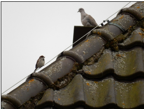
Figuur 10. Huismus en Turkse tortel op het dak van de woonboerderij.
