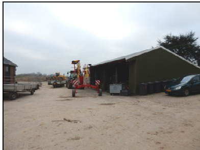
Figuur 4. Kapschuur opgebouwd uit damwandplaten.
