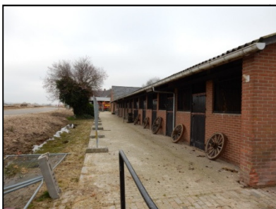
Figuur 6. Westelijk deel manegeschuur.
